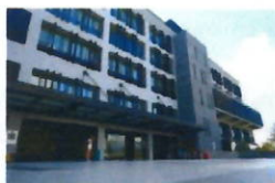
Frontis Edificio B.
